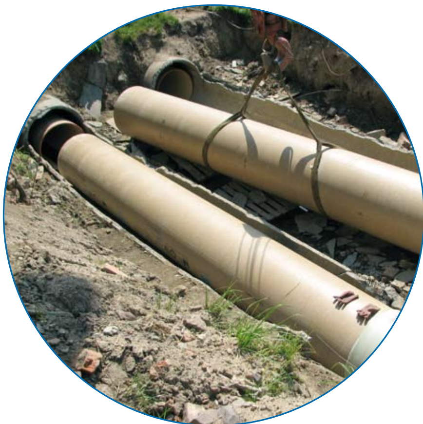
Montaż rur GRP
