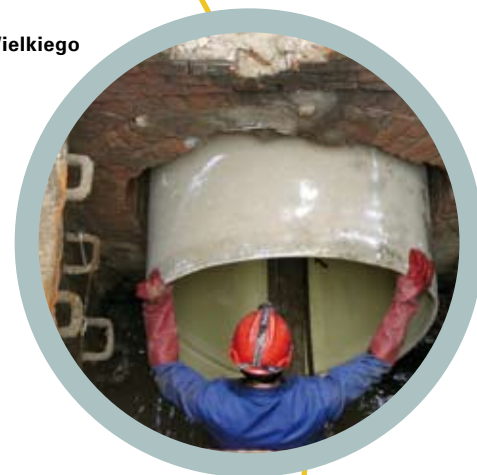
Wrocław, ul. Kazimierza Wielkiego – warunki pracy
