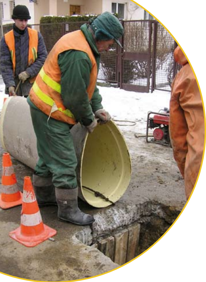
Kraków, ul. Domeyki – wprowadzanie panelu NC Line® do istniejącego kanału
