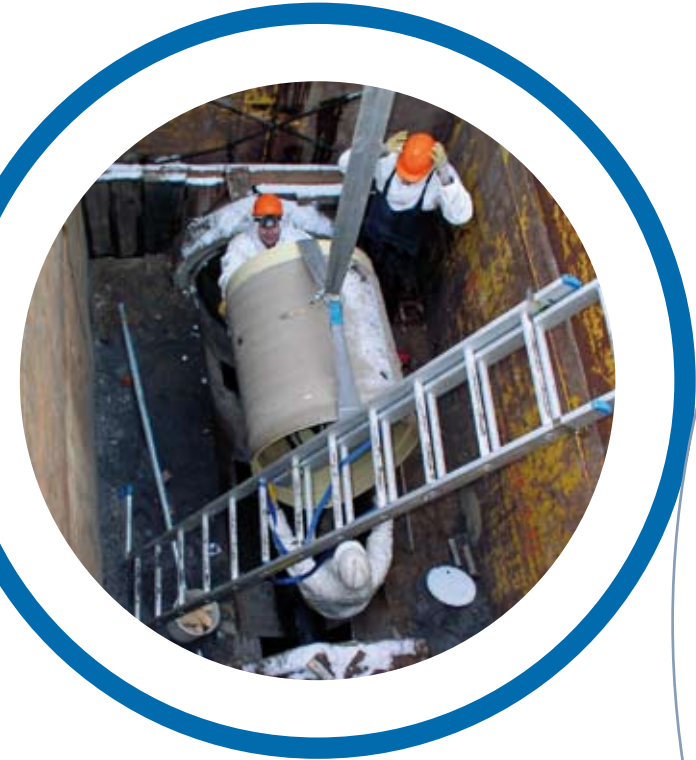
Szczecin, ul. Sikorskiego – montaż paneli NC Line® – zdjęcie do obróbki
