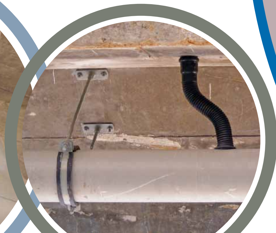
Rys 3.9 Obwodnica Wyszkowa, Wiadukt WD7
