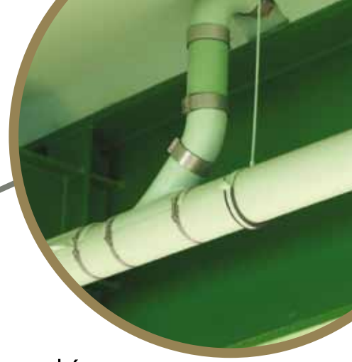
Rys. 3.1 Podłączenie wpustu mostowego do przewodu zbiorczego
